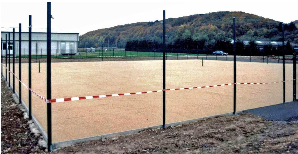
Jetzt sind die Plätze für die Verlegung des Kunstrasens hergerichtet
