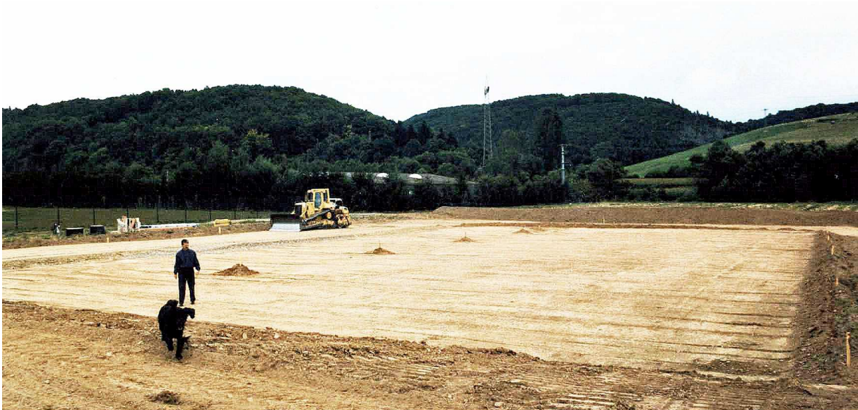
Willi Lehnen und sein Hund Ronja begutachten den Baufortschritt
