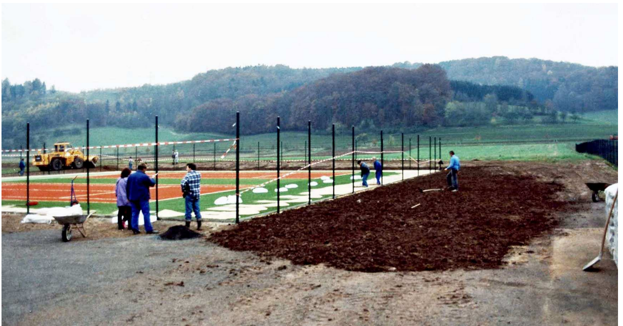
Während die Besandung des Kunstrasens beginnt, wird um die Anlage Mutterboden verteilt
