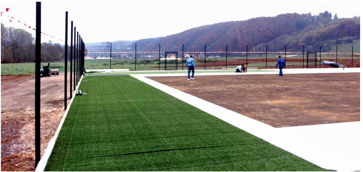
Werner Thielen überwacht das Verlegen der Kunstrasenbahnen
