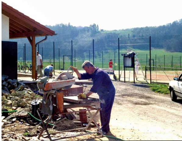
Helmut schneidet die Rand- und Verbundsteine, Willi und Fred pflastern die Terrasse
