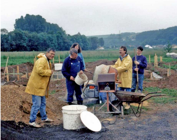
Im nächsten Arbeitsgang werden die Fundamente von Norbert, Helmut, Christian, Willi und Rolf betoniert und dann mit Kellersteinen von Fred Spath abgemauert
